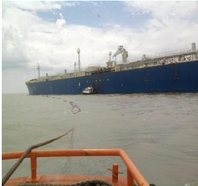
Ilustración 13. Luego del amarre la lancha de amarre acercará la manguera al sector del manifold del buque.
