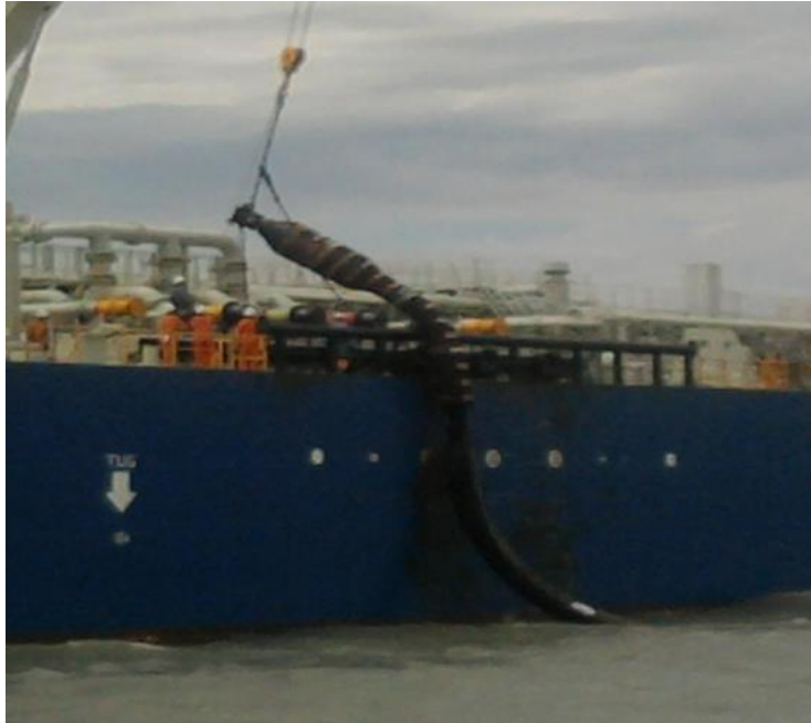
Ilustración 15. Luego que la manguera se hace firme a la cubierta, la misma se quiebra en el lomo de ballena en dirección a la boca de conexión.
